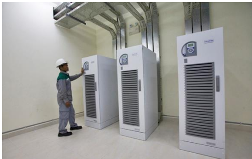
Sotelco Data Center (Cambodia)
